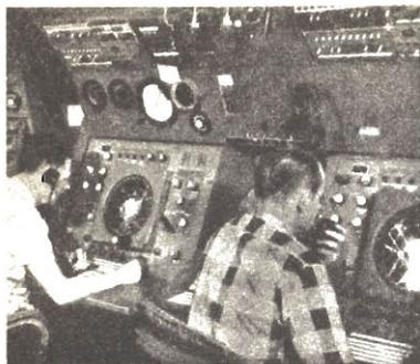
Consolles di controllo radar per la copertura degli spazi aerei.
